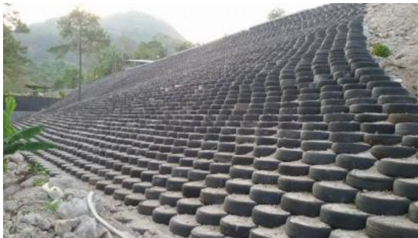
Ilustración 22: Zonas de acondicionamiento mediante colocación de residuos.
