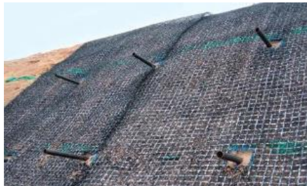
Ilustración 24: El revestimiento de los taludes mediante geomalla sintética antierosión
